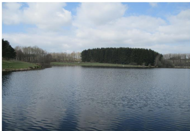
Foto gegen Fließrichtung
