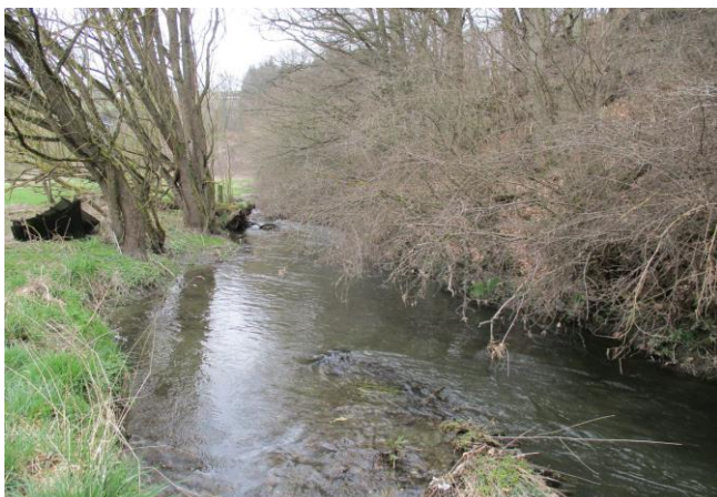
Foto gegen Fließrichtung
