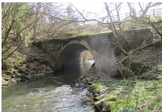
Foto gegen Fließrichtung
