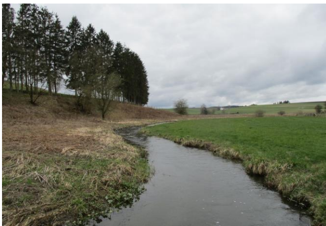
Foto gegen Fließrichtung
