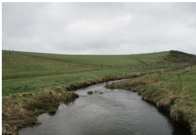
Foto gegen Fließrichtung
