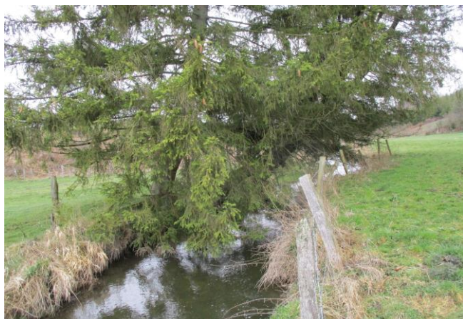
Foto gegen Fließrichtung
