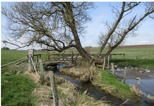
Foto gegen Fließrichtung
