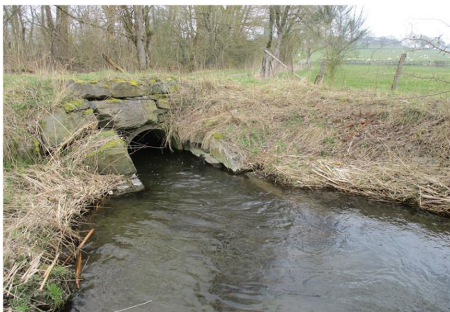
Foto gegen Fließrichtung
