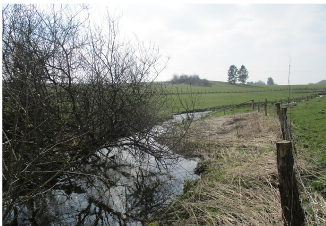
Foto gegen Fließrichtung
