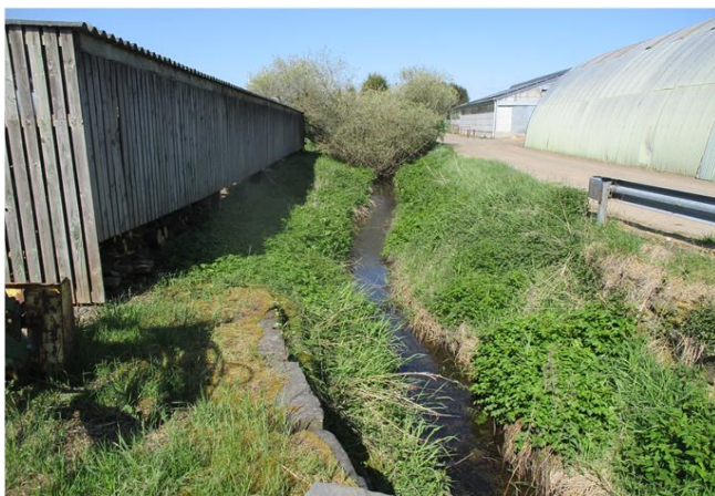
Foto gegen Fließrichtung
