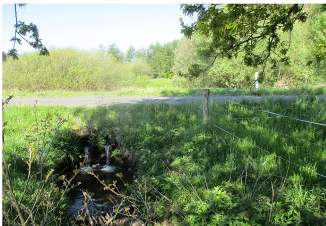
Foto gegen Fließrichtung
