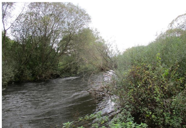
Foto gegen Fließrichtung
