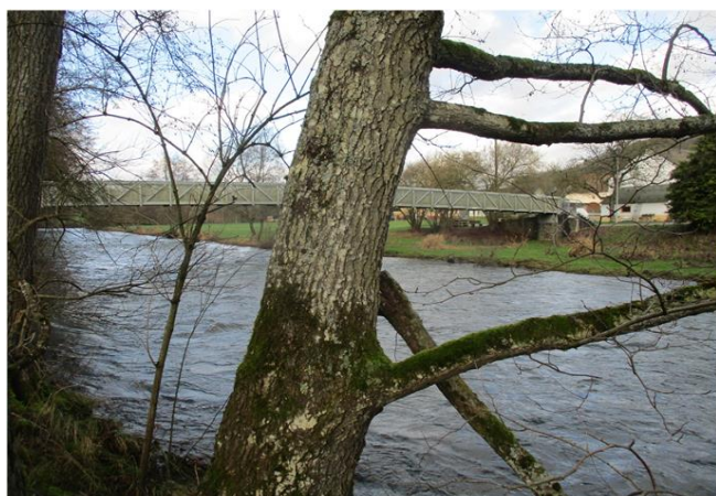
Foto gegen Fließrichtung
