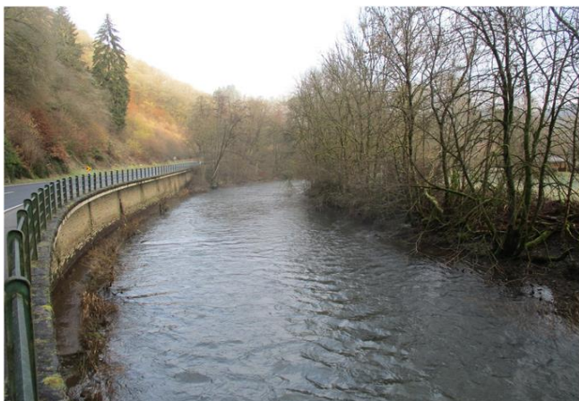
Foto gegen Fließrichtung
