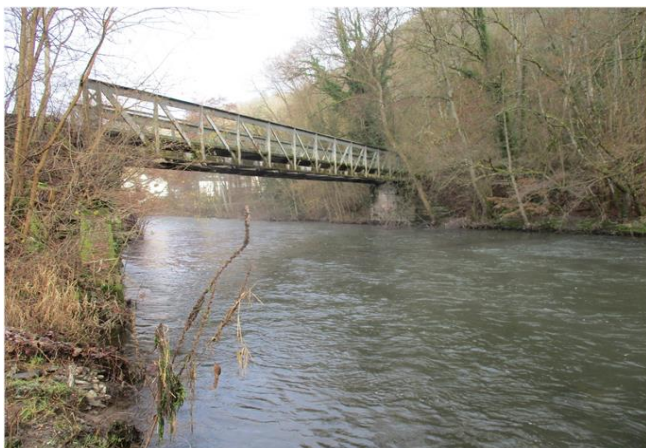
Foto gegen Fließrichtung
