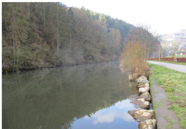
Foto gegen Fließrichtung
