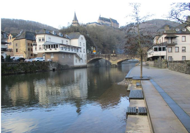
Foto gegen Fließrichtung
