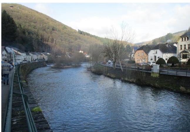
Foto gegen Fließrichtung
