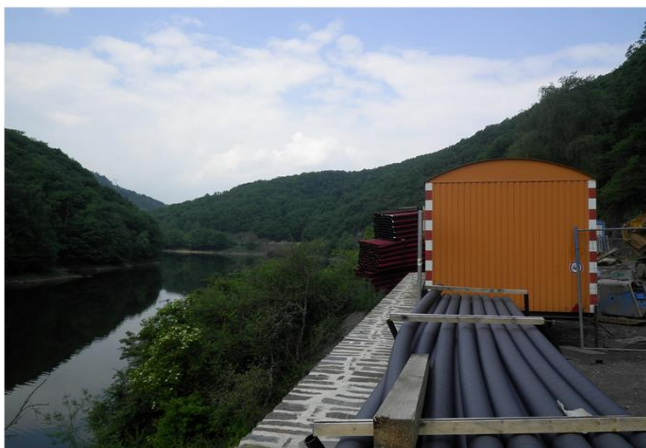
Foto gegen Fließrichtung
