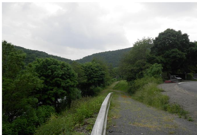
Foto gegen Fließrichtung
