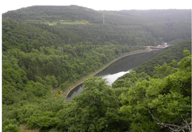
Foto gegen Fließrichtung
