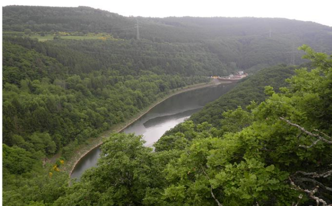
Foto gegen Fließrichtung
