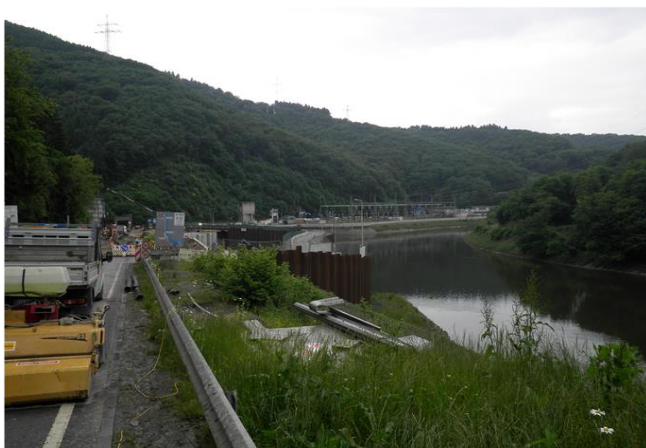
Foto gegen Fließrichtung
