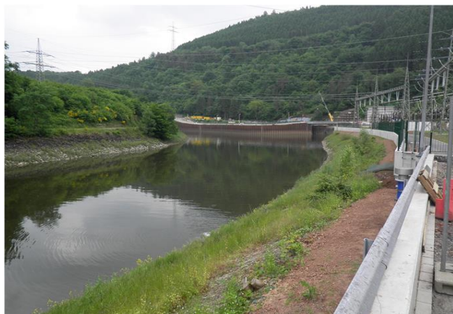
Foto gegen Fließrichtung
