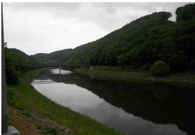
Foto gegen Fließrichtung
