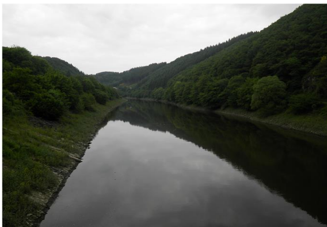
Foto gegen Fließrichtung
