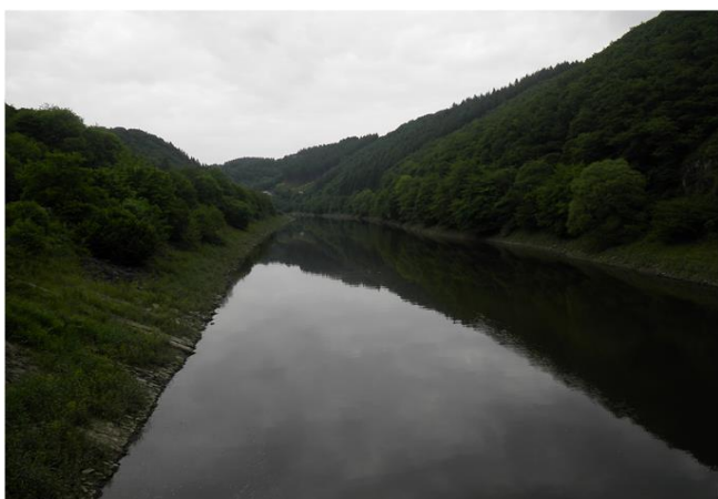
Foto gegen Fließrichtung
