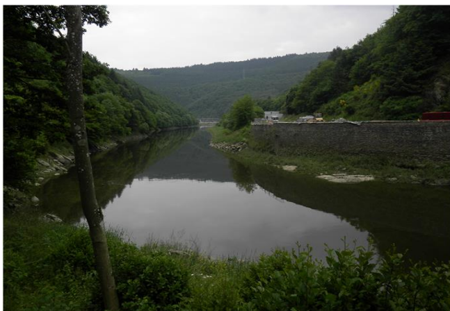
Foto gegen Fließrichtung
