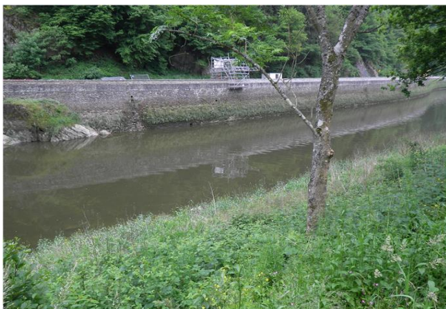
Foto gegen Fließrichtung
