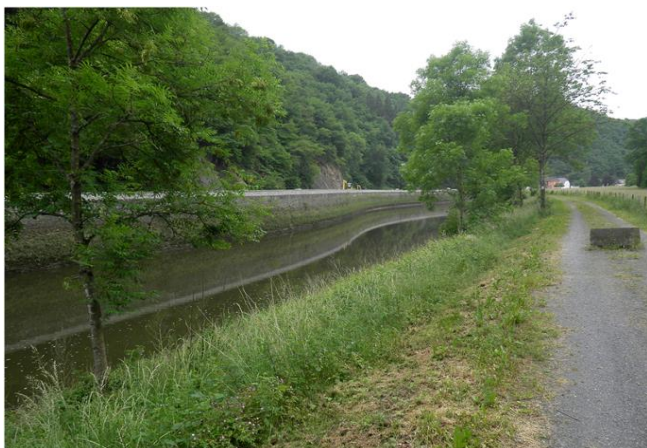
Foto gegen Fließrichtung
