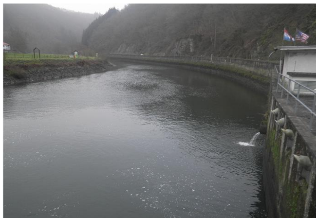
Foto gegen Fließrichtung
