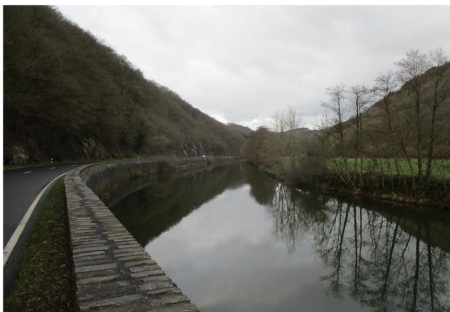
Foto gegen Fließrichtung
