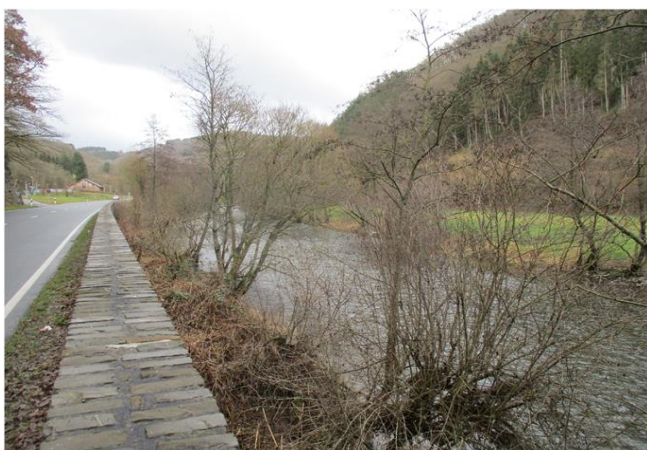
Foto gegen Fließrichtung
