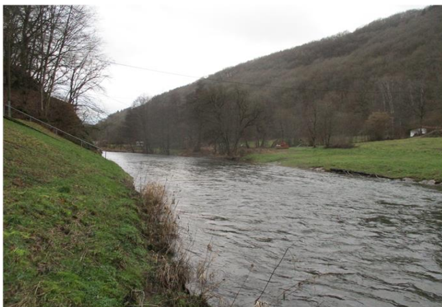
Foto gegen Fließrichtung
