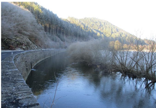
Foto gegen Fließrichtung
