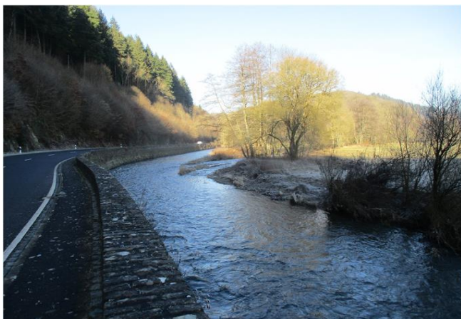
Foto gegen Fließrichtung
