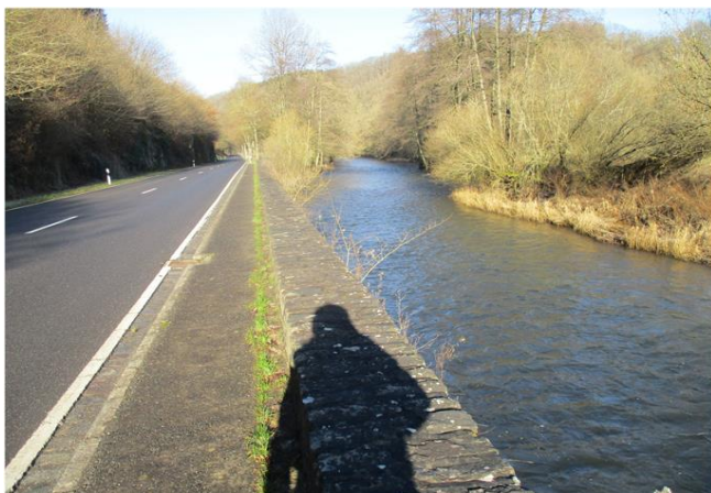
Foto gegen Fließrichtung
