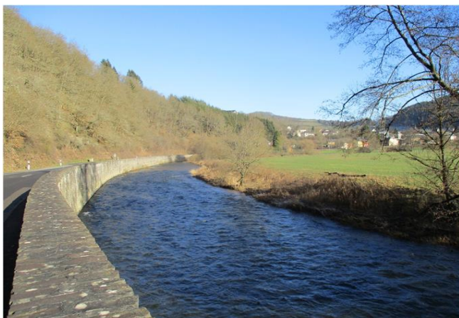
Foto gegen Fließrichtung
