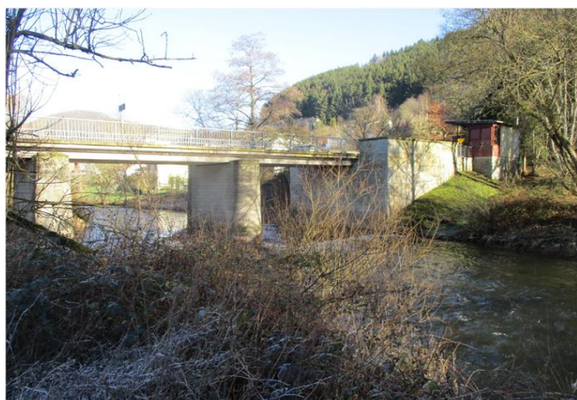
Foto gegen Fließrichtung
