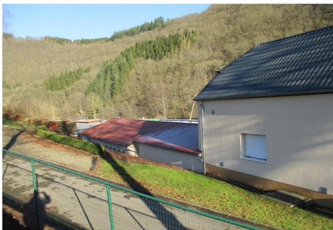
Foto gegen Fließrichtung
