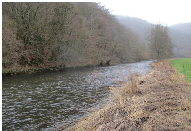
Foto gegen Fließrichtung
