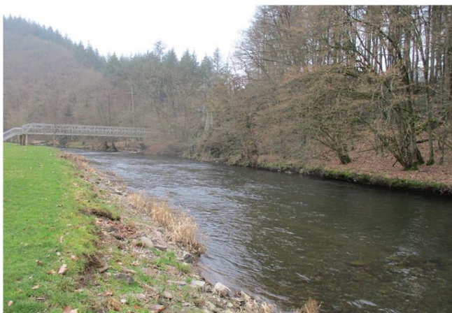
Foto gegen Fließrichtung
