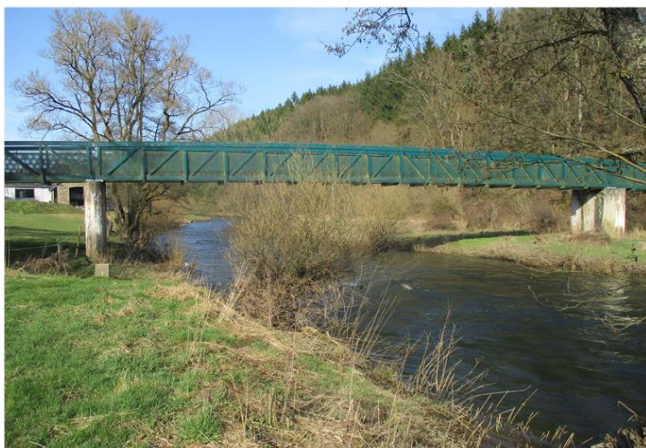
Foto gegen Fließrichtung
