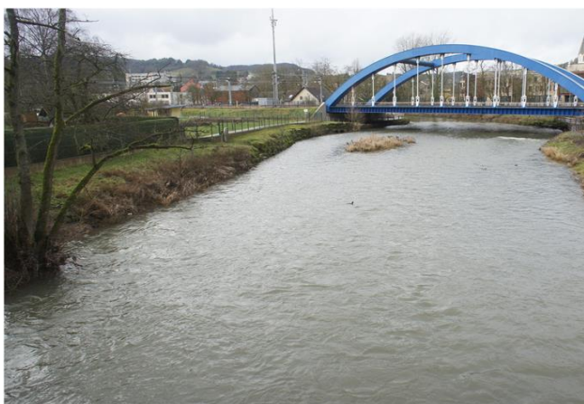
Foto gegen Fließrichtung
