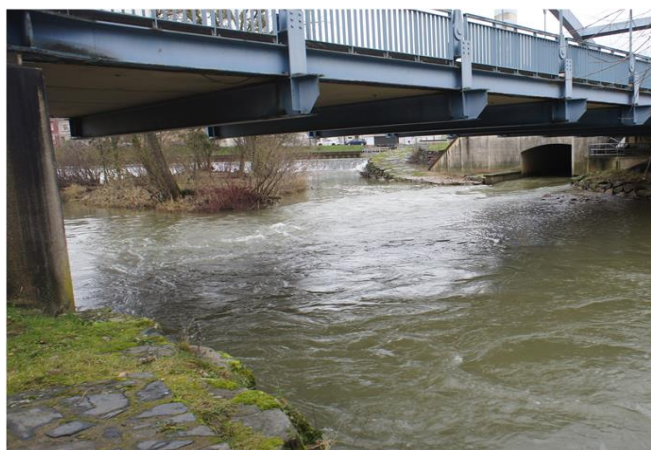
Foto gegen Fließrichtung
