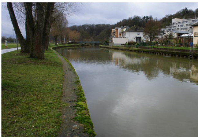
Foto gegen Fließrichtung
