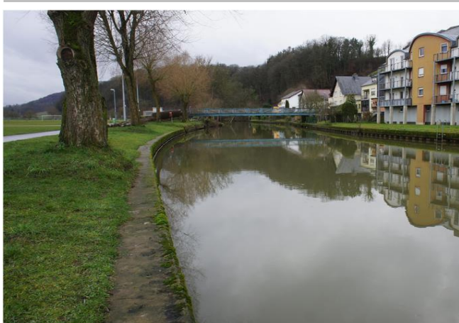
Foto gegen Fließrichtung
