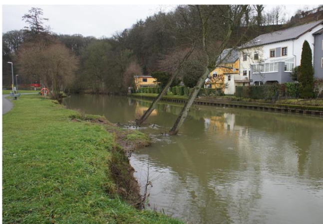
Foto gegen Fließrichtung
