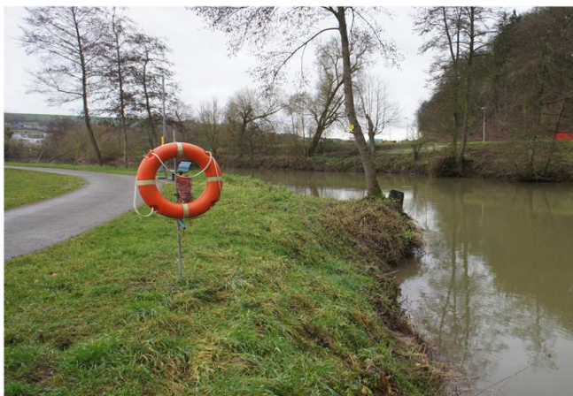
Foto gegen Fließrichtung
