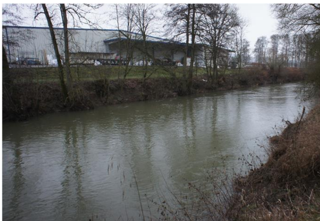
Foto gegen Fließrichtung
